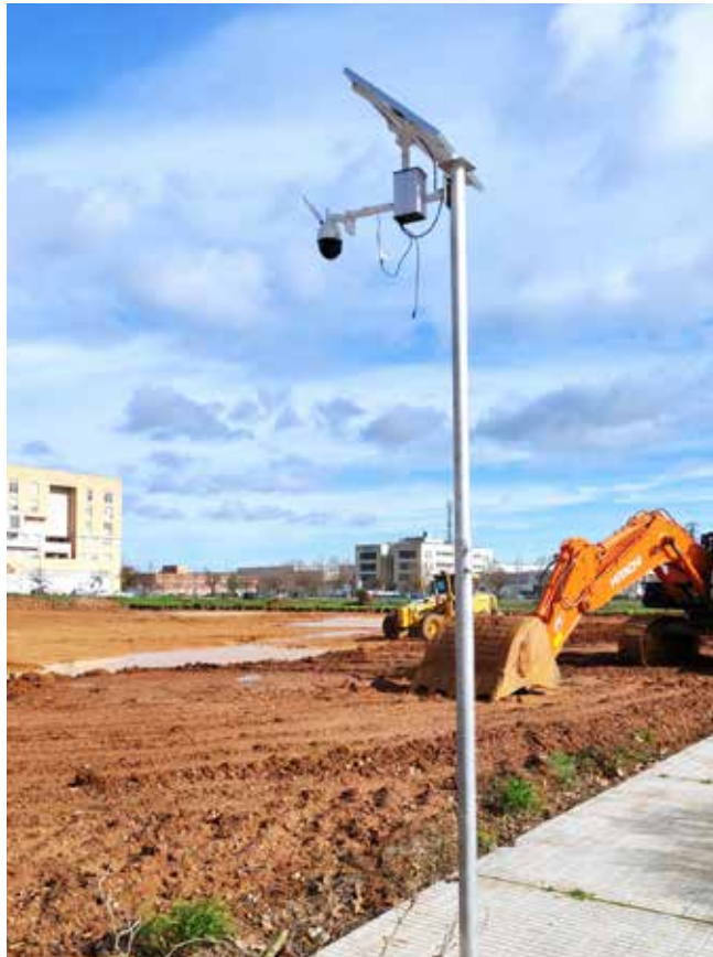
Pie de foto: Instalación de Neurona en la construcción de la Nueva Sede (Badajoz)
